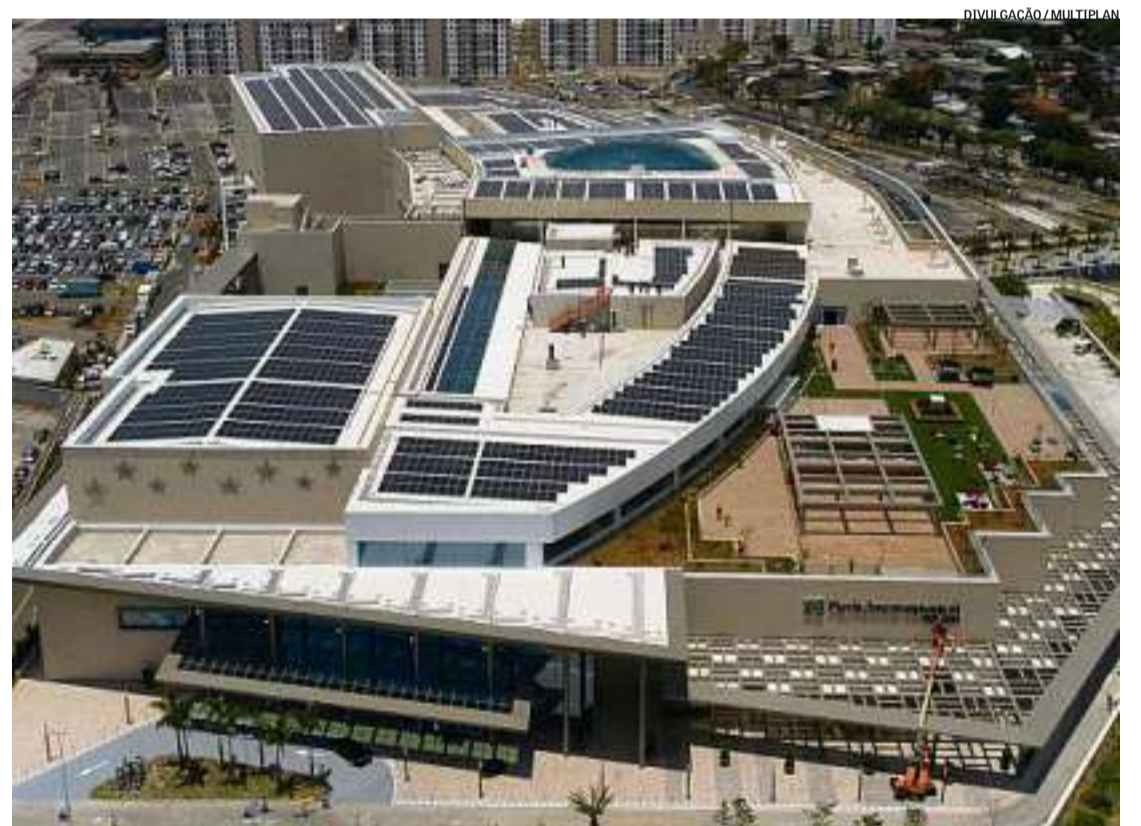
Inaugurado em novembro, o ParkJacarepaguá tem uma usina com 3.686 painéis solares instalada no teto do prédio
