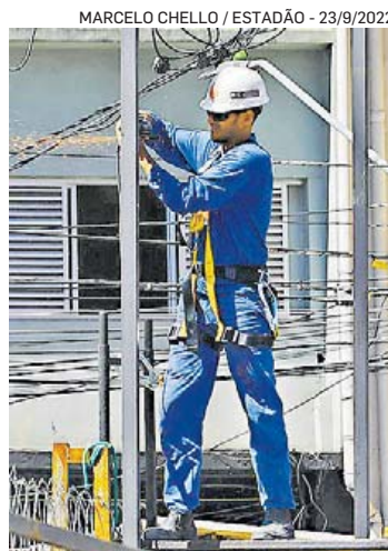
Trabalhador em obra de SP; retorno de material reciclado
